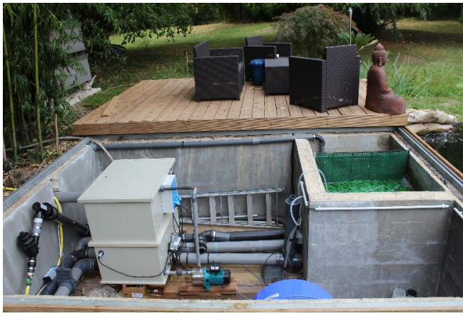
La terrasse coulisse et découvre le local technique enterré.
