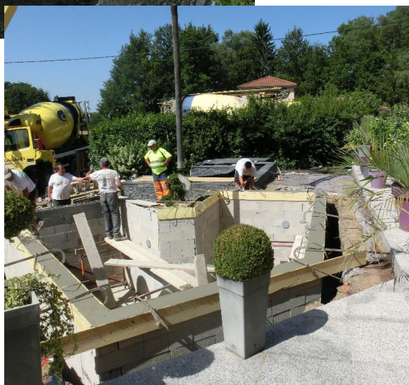
Les bondes de fond et les armatures mises en place, coulage du radier et début du montage des blocs à bancher.
