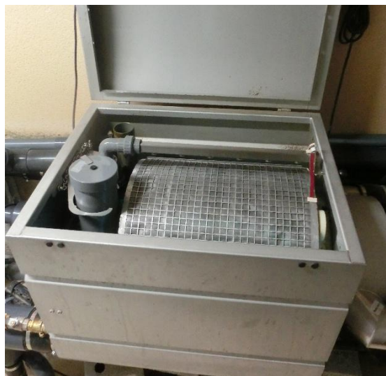
2 pompes de 20 m 3 /h alimentent le filtre.
