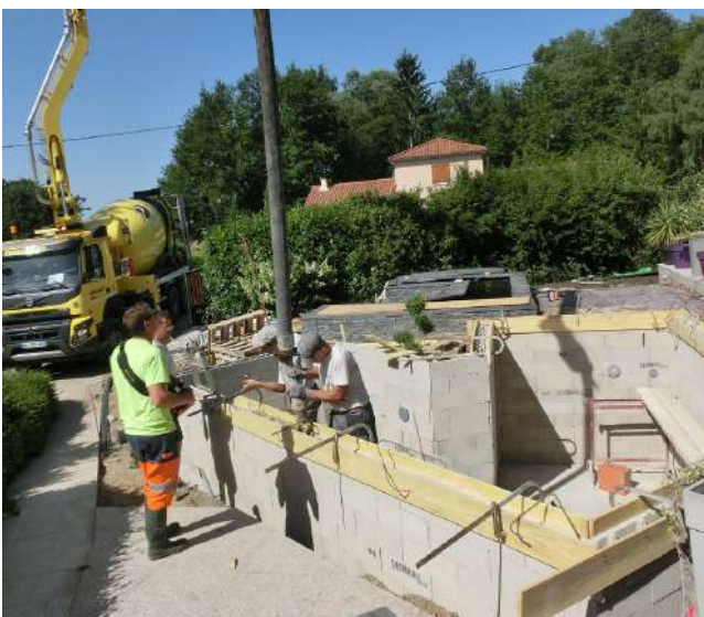
Coulage (en grande pompe).
