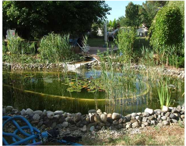
photo 2 : vue de la lagune zone de sur-profondeur en arrière plan, vue sur le déversoir
